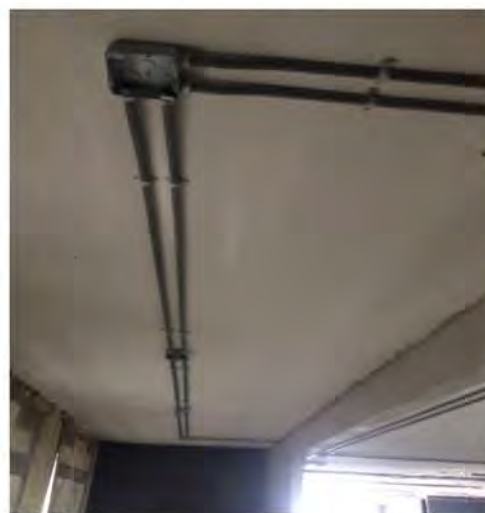
รูปภาพงานเดินท่อระบบ M&E บริเวณลานจอดรถชั้น 8
