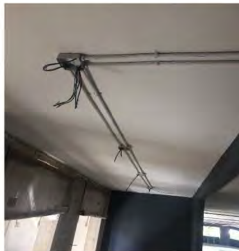
รูปภาพงานเดินท่อระบบ M&E บริเวณลานจอดรถชั้น 6
