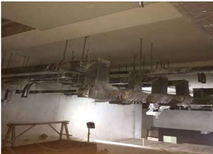
รูปภาพงานติดตั้ง BUSDUCT ภายในห้องเครื่อง ชั้น 11
