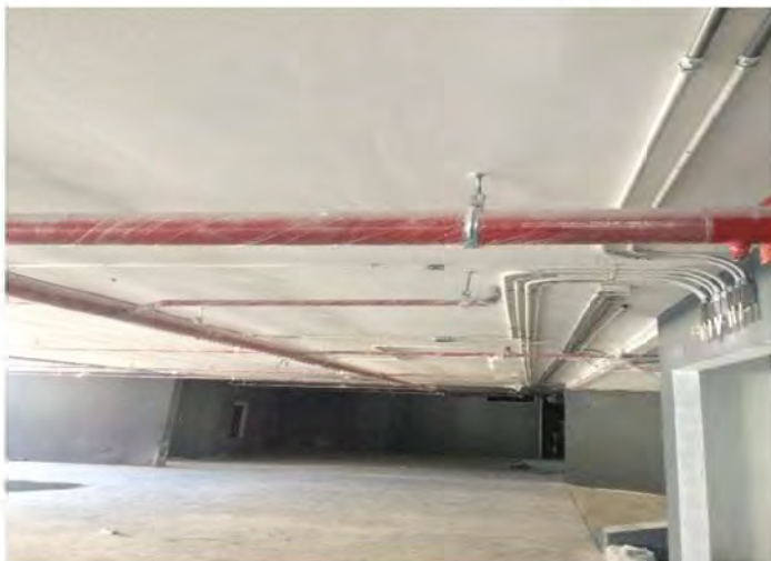
รูปภาพงานเดินท่อระบบ M&E บริเวณลานจอดรถชั้น 6
