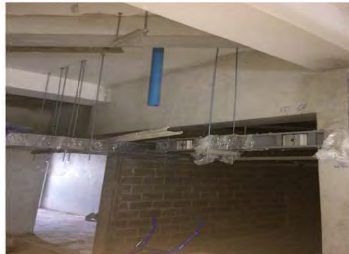
รูปภาพงานติดตั้ง BUSDUCT ภายในห้องเครื่อง ชั้น 11
